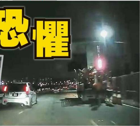
根据李明康行车记录仪拍摄的画面, 可见一辆罗里在没有置放障碍物的情况下, 停在快速车道工作; 工作人员也未穿上反光衣, 驾驶者难以注意到他们。
